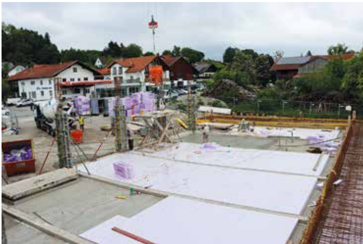
Bodenplatte der Fahrzeughalle.
