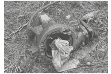
Beispiel für eine verstopfte Pumpe im Kanalnetz:
